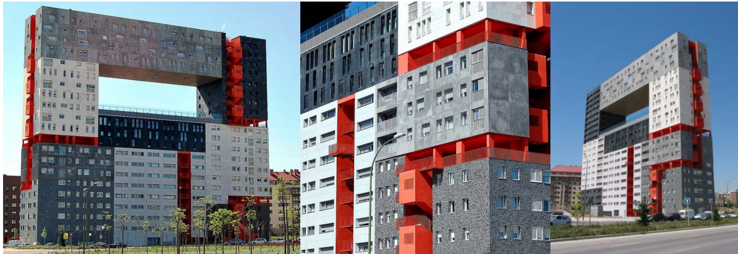
mvrđv. stambena zgrada
